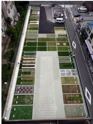
図1. 実験区の全景
